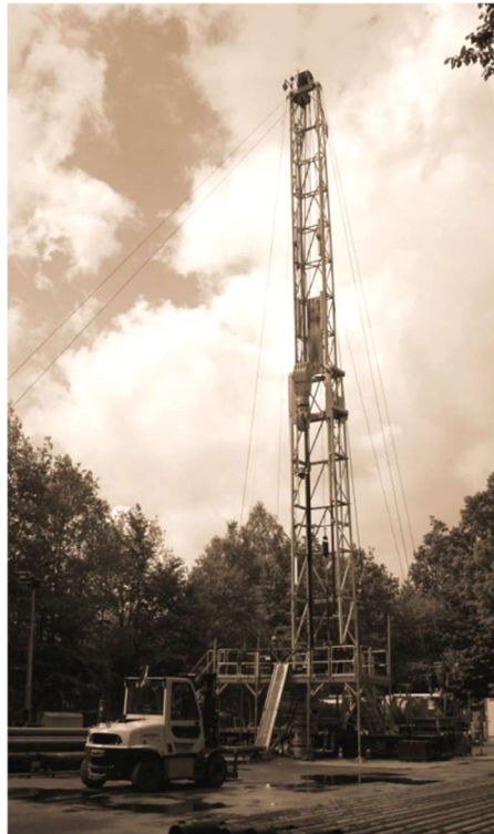
Die Workover-Winde Cabot Franks 650 während einer Verfüllungsarbeit.
