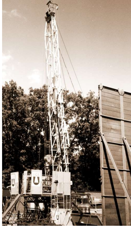
Die Cabot Franks 200 Workover-Winde im Einsatz, kombiniert mit einer Lärmschutzwand.
